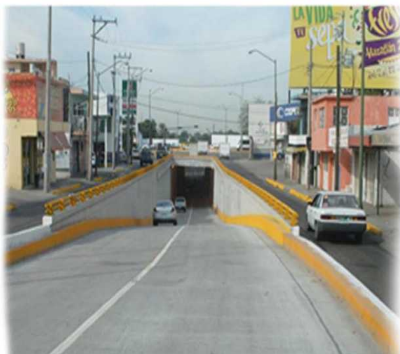
Imagen del "Eje Federalismo". Ubicado en uno de los lugares más privilegiados de la ciudad, se optó por una solución cuestionable ya que la experiencia nos ha enseñado que la prevención y eficiencia en el manejo de contingencias de fenómenos naturales deja mucho que desear. Estéticamente limitada y funcionalmente absurda denota ser una ocurrencia de quienes siendo autoridad invaden de manera impune disciplinas de especialistas. De inicio ha final se evidenció la falta de un proyecto y las preocupaciones sociales. Foto de archivo personal, tomada el 15 de febrero de 2013.
